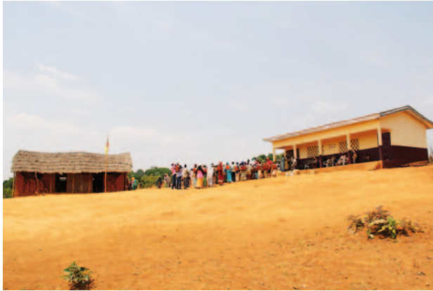
Mayo Goum: unser neu erbautes Schulhaus.
