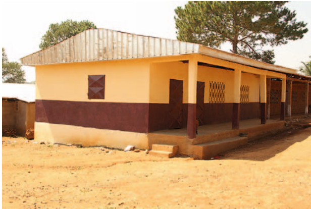
Der neue Primarschulhaus-Anbau in Mayo Darle.
