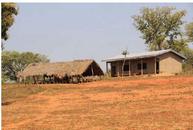
Das alte und das neue Schulhaus von Mayo Boutaly.
