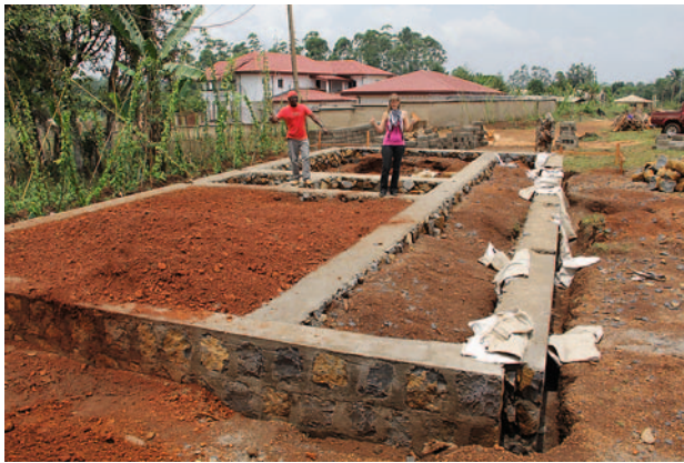
Bawock: das Fundament für unsere neue Schule.
