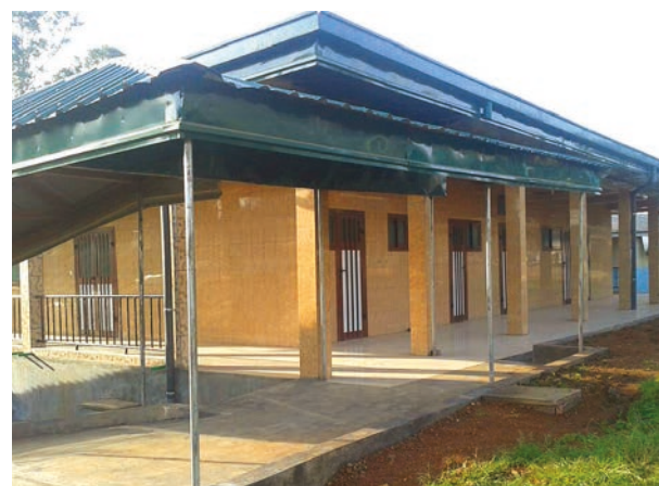
Mai 2018: Kurz vor der Fertigstellung und Eröffnung unseres neuen Operationssaals in Bali Nyonga wurde der Aufbau durch die politischen Unruhen gestört und dadurch erheblich verzögert.
