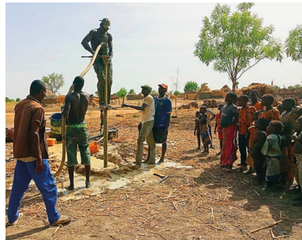
April 2019: Brunnenbohrung durch Handarbeit in Galam Foulda / Nähe Gobo.
