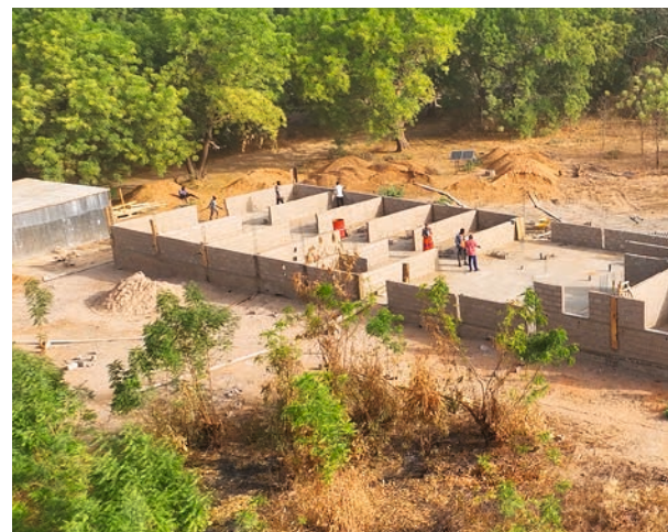
Unser Kinderspital (Pädiatriezentrum) in Yagoua nimmt Form an.
