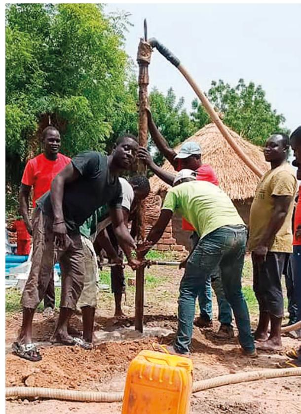
*Arbeiter an der Brunnenbohrung in Dom-Souloukou. Unsere Bohrlöcher gehen wenn immer möglich 50 bis 60 Meter tief.*
